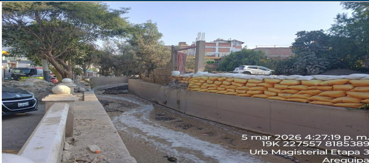
IMAGEN 01: SE OBSERVA LOS DAÑOS QUE HA OCASIONADO LA CRECIDA DE LA QUEBRADA CHULLO, EN LAS VIVIENDAS CERCANAS A SU CAUCE, EN DONDE ALGUNOS POBLADORES HAN COLOCADO SACOS DE ARENA COMO PROTECCIÓN; TAMBIEN SE OBSERVA QUE SE ENCUENTRA COLMATADO DE SEDIMENTOS.
